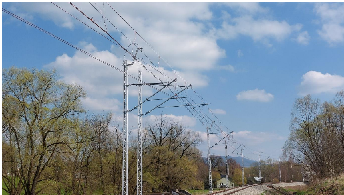
Szlak Goleiszów – Cieszyn w Cieszynie. Stan na kwiecień 2022.
